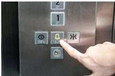
Les lignes de sécurité d'ascenseur
