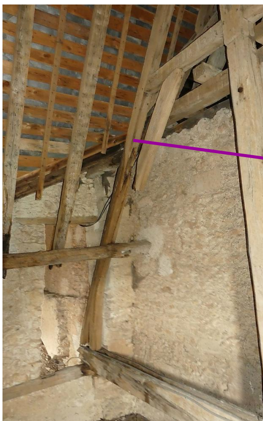
Chapelle Sainte-Radegonde (sud), lien désassemblé, bois pourri suite à l'infiltration
