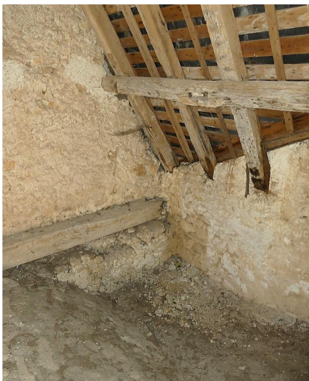
Chapelle Sainte-Radegonde (sud), importante dégradation suite à une noue fuyarde. Contrefiche de renfort de la panne modifiant le schéma statique de la ferme sur laquelle elle s'appuie. Panne sablière ne reliant pas toutes les fermes
