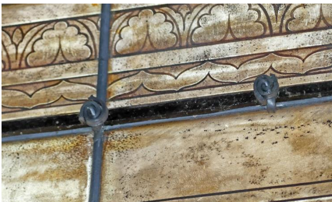
Baie 8 (façade sud), vergette peinte et attaches de vergette neuves
