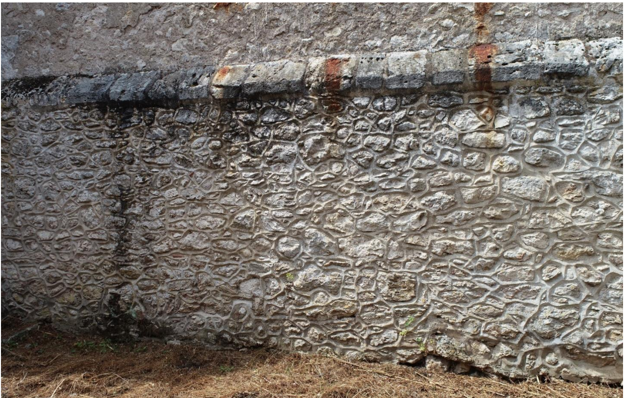
Façade sud, soubassement avec des joints saillants très « datés », à base de mortier hydraulique, pollution microbologique en partie haute et léger déchaussement en pied de mur
