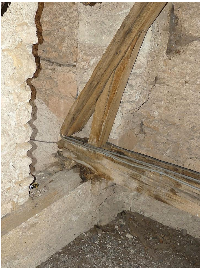
Chapelle Sainte-Radegonde (sud), pied de ferme ruiné et perte de matière importante au cœur du bois de l'entrait suite à l'infiltration
