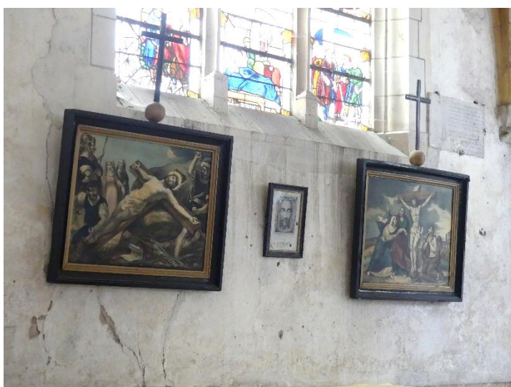
Murs gouttereaux nord et sud, traces de coulures sur les appuis et sous les baies des bas-côtés
