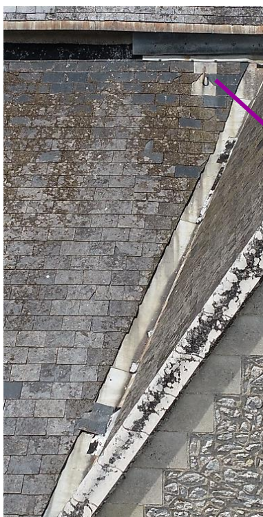
Jonction entre le bas-côté sud et la chapelle Sainte-Radegonde, zingueries corrodées, noue vétuste comprenant des réparations provisoires, présence d'ardoise dans la noue, stationnement de pigeons contribuant à dégrader les ardoises
