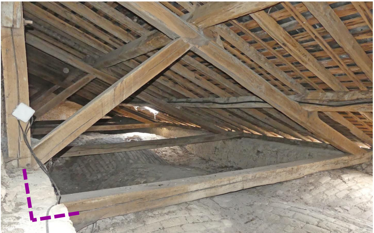
Demi-ferme du bas-côté sud, l'assemblage entrain-poinçon est noyé dans la maçonnerie (l'existence de la liaison a été vérifiée par un sondage effectué dans le mur)
