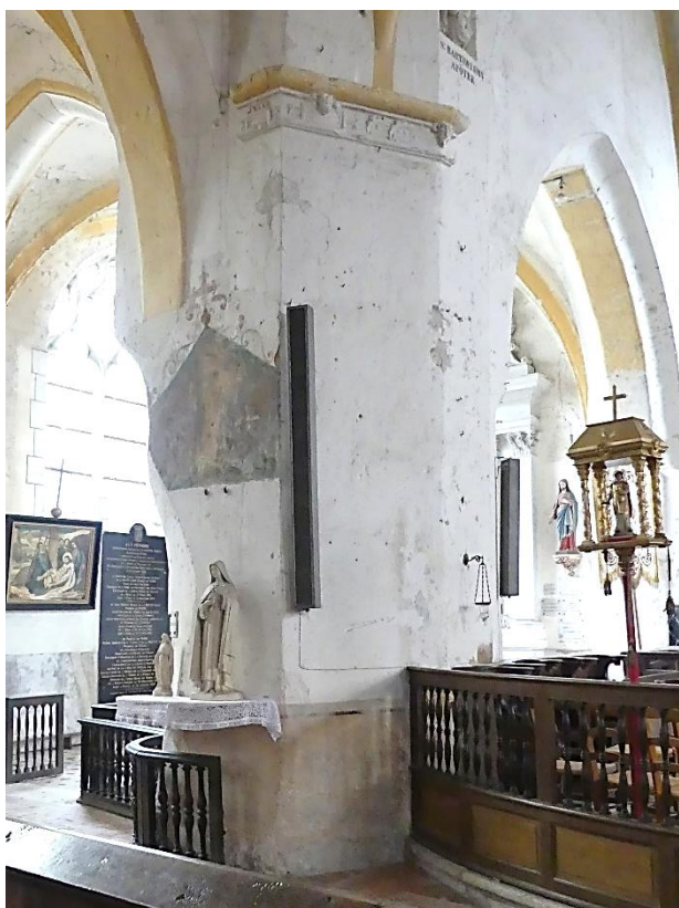
Système de sonorisation par enceintes fixées sur les piliers à la jonction entre la nef et le chœur
