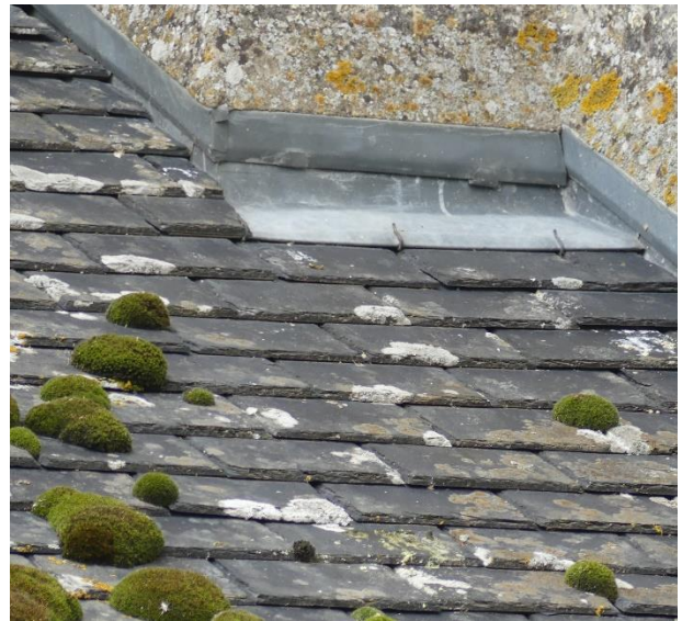
Porche d'entrée, ardoises épaisses posées au clou en relativement bon état, pollution microbologique (mousse et lichen) localisée
