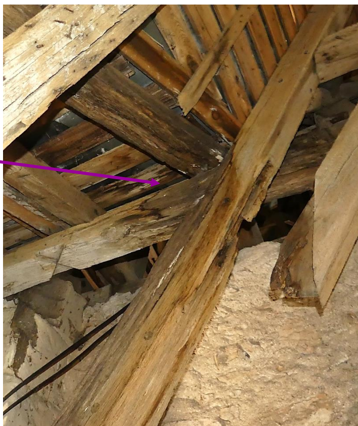
Chapelle Sainte-Radegonde (sud), lien désassemblé, bois pourri suite à l'infiltration
