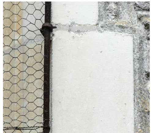
Façade nord, baie 5, meneau et encadrement pierre récemment mis en œuvre
