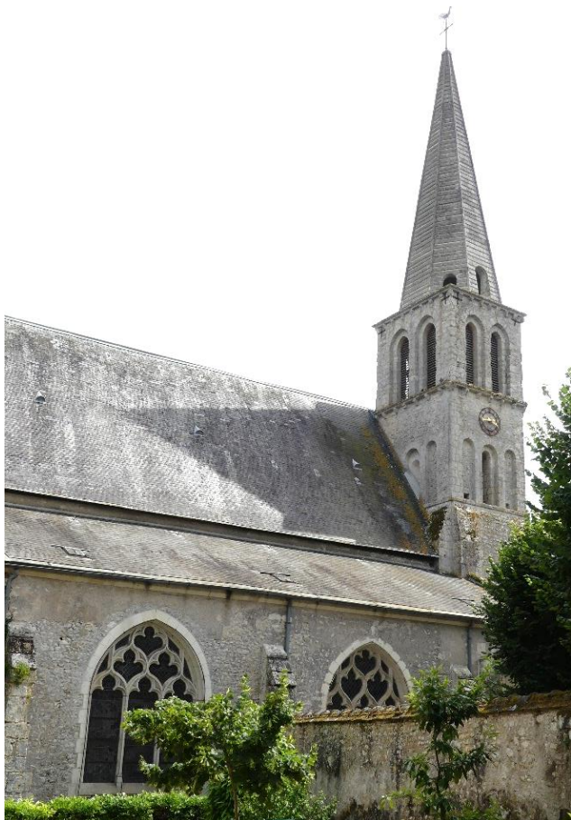
Bas-côté nord divisé par le mur de clôture du parc du château
