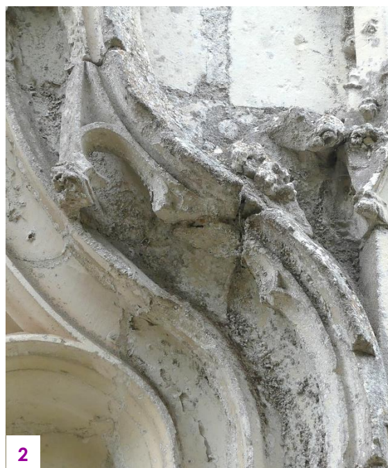
Parement pulvérulent sur le chemin d'écoulement des eaux de pluie
