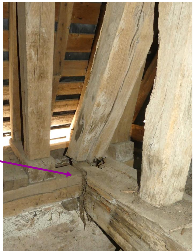
F4 (nef), rupture de l'assemblage au niveau du pied de ferme suite à une infiltration. La zone a été étayée par une jambe de force en-dessous
