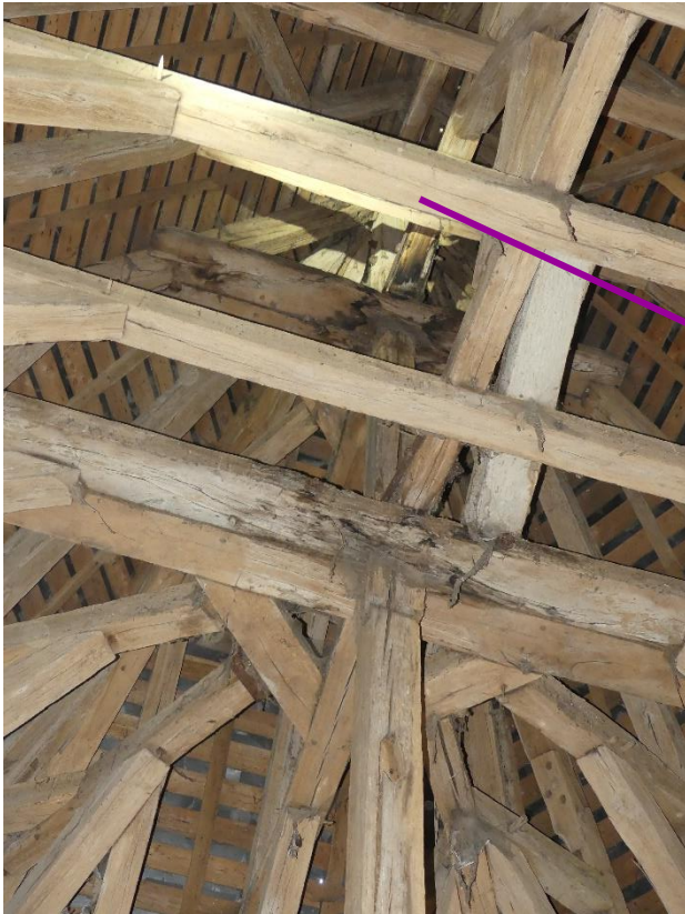
F8 (chœur), multiplication des infiltrations au niveau du poinçon ayant altéré les bois (panne faitière et poinçon ruinés localement)
