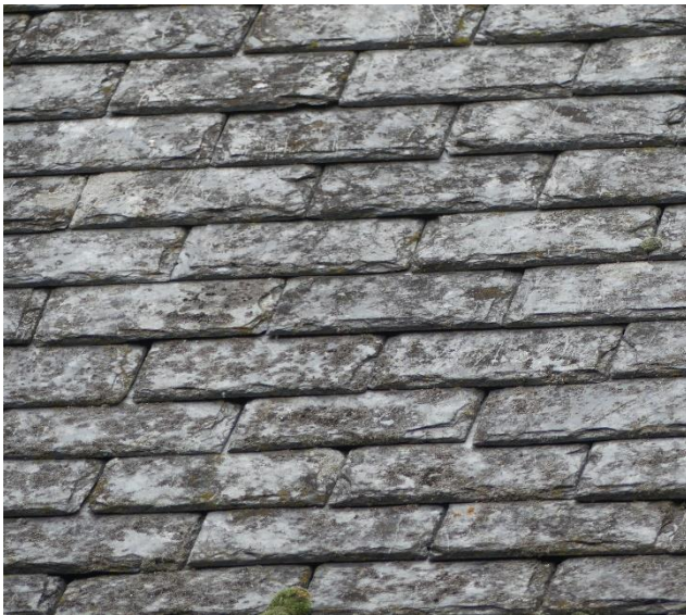
Porche d'entrée, ardoises épaisses posées au clou en relativement bon état, pollution microbologique (mousse et lichen) localisée
