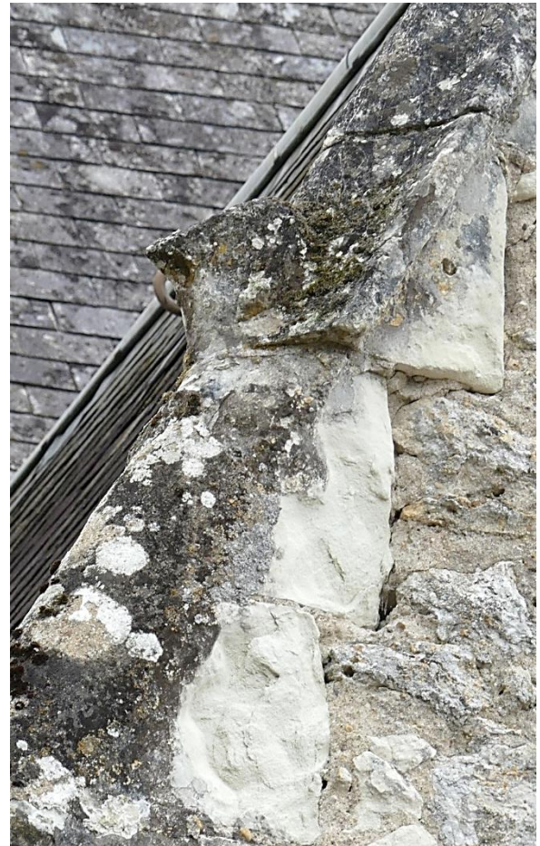
Chevronnière est de la chapelle nord, desquamation avec importante perte de matière vestiges de crochets
