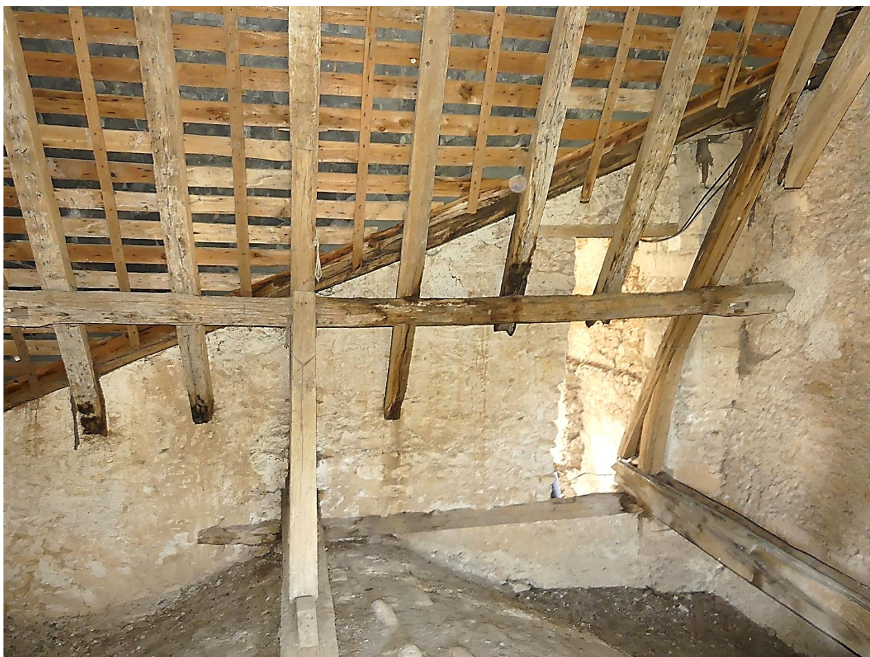
Chapelle Sainte-Radegonde (sud), importante dégradation suite à une noue fuyarde. Contrefiche de renfort de la panne modifiant le schéma statique de la ferme sur laquelle elle s'appuie. Panne sablière ne reliant pas toutes les fermes
