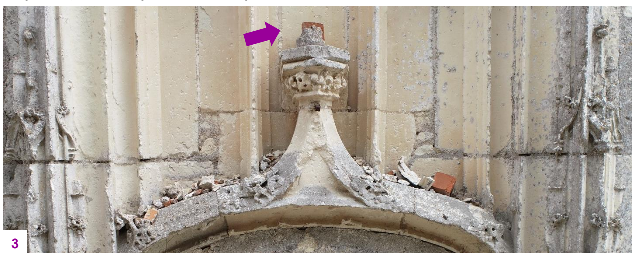
Chutes de fragments de pierre, de plâtre et de brique sur l'arc en anse de panier ; les fragments en plâtre et en brique proviennent du fleuron sans doute restitué par Anatole de Baudot à la fin du XIXe siècle.
