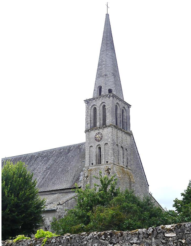
Angle nord-ouest de l'église depuis la rue du Bourg
