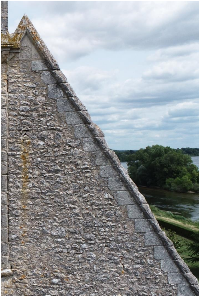
Chevronnière du pignon ouest, perte de matière, déjointoiement, vestiges de crochets, partie sommitale issue d'une restauration
