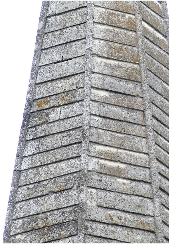
Flèche, forte pollution microbologique, quelques joints lacunaires, légères épaufures
