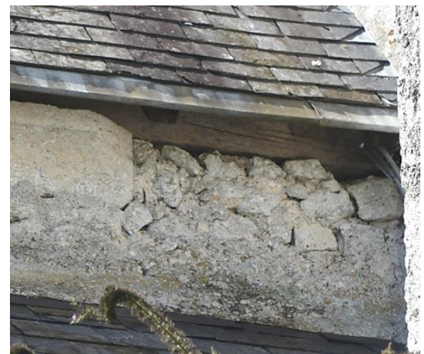
Jonction chapelle nord-bas-côté nord, gouttière non raccordée à la descente d'eaux pluviales laissant les eaux ruisseler sur les parements
