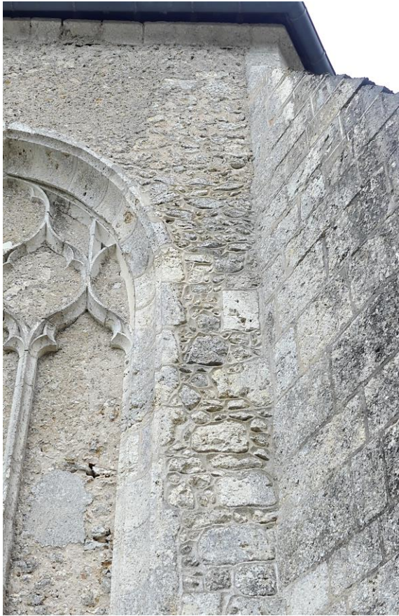
Ancienne baie axiale (chevet), relancis de moellons avec des joints saillants à base de mortier hydraulique
