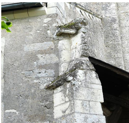
Angle nord-ouest du bas-côté, ancienne gargouille fracturée dont il ne reste qu'une partie. On identifie des jambes sculptées sur le fragment restant, vestige d'un probable personnage dont le tronc a disparu
