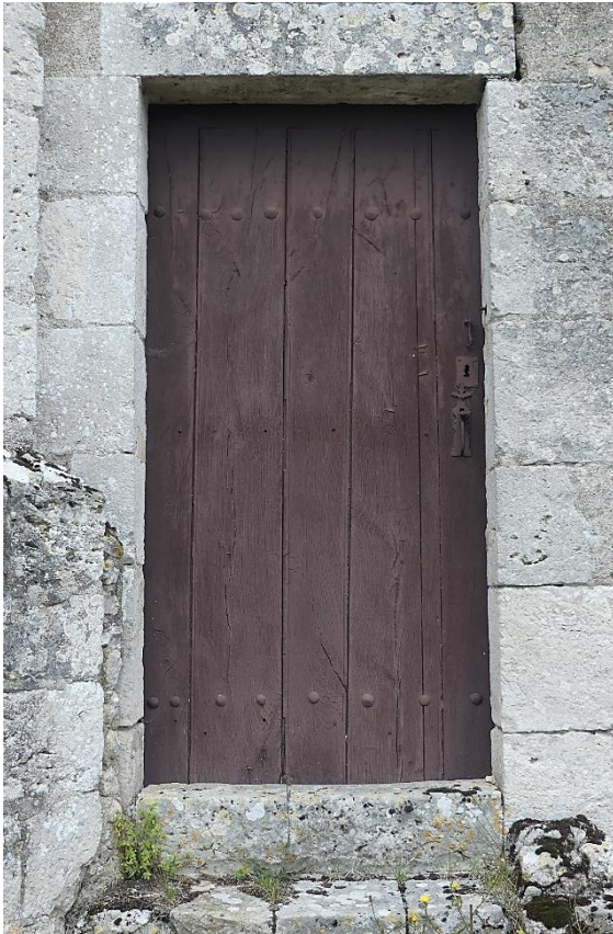
Façade sud, porte de la sacristie, face intérieure sans couche protectrice et pentures oxydées
