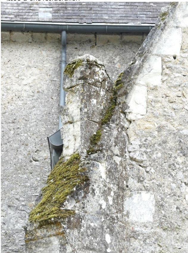
Chevronnière du pignon ouest, perte de matière, déjointoiement, vestiges de crochets, partie sommitale issue d'une restauration
