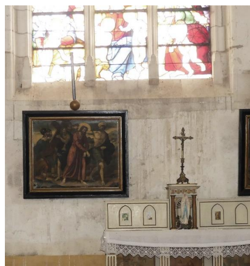
Murs gouttereaux nord et sud, traces de coulures sur les appuis et sous les baies des bas-côtés
