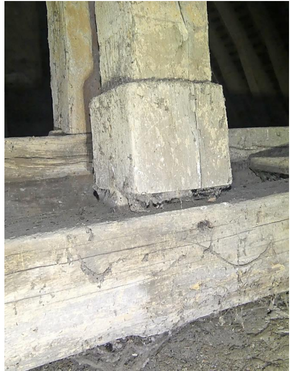
F3b, assemblage poinçon-entrait ouvert
