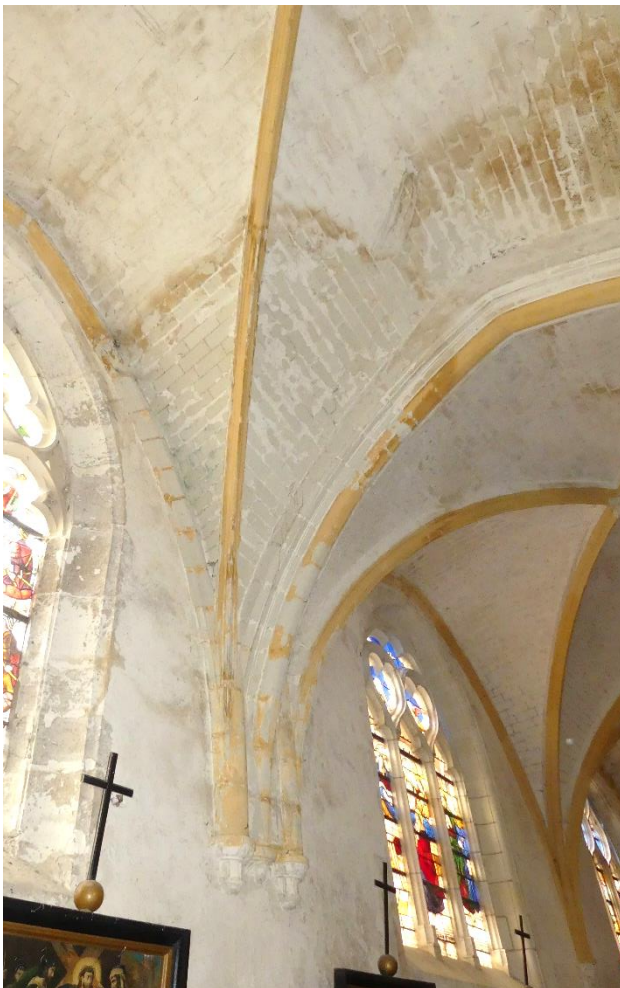
Chapelle Sainte-Radegonde (sud), traces d'infiltration sur l'intrados de la voûte
