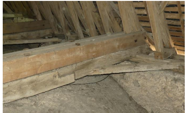
F6 (chœur), extrémité de l'entrait remplacée par enture et ensemble renforcé par moisage
