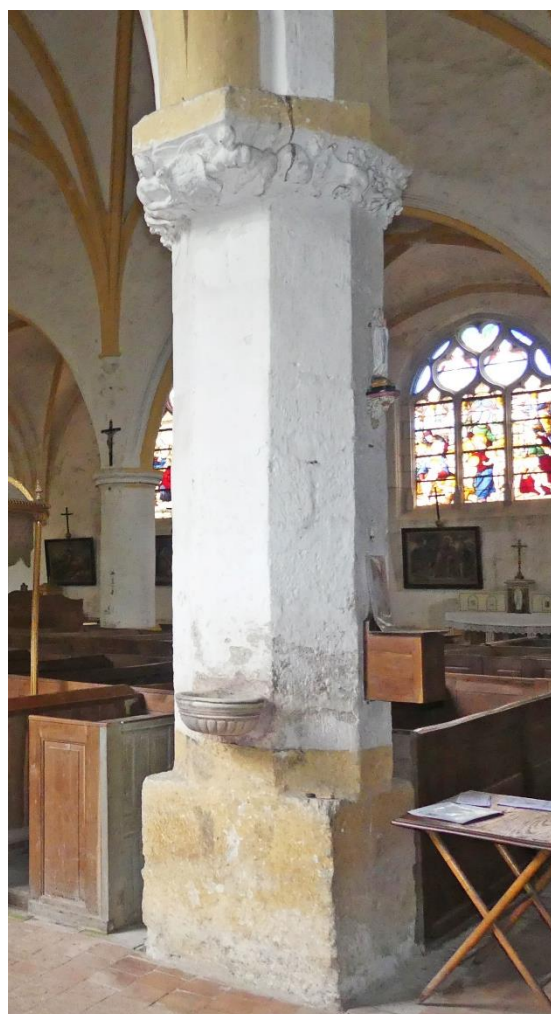
Bas-côté nord, pile octogonale avec chapiteau frisé
