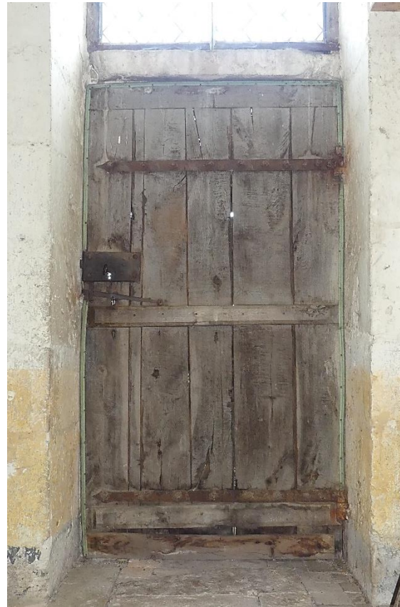
Façade sud, porte de la sacristie, face intérieure sans couche protectrice et pentures oxydées
