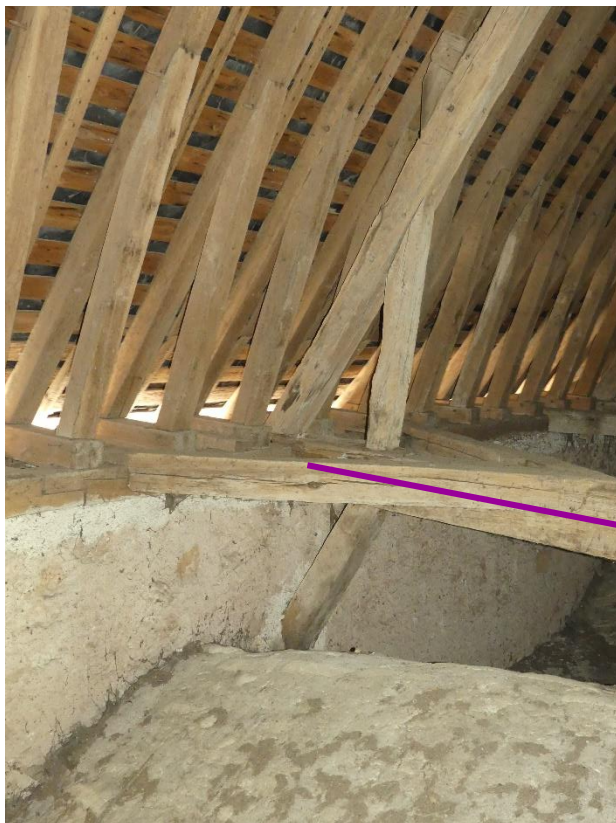
F4 (nef), rupture de l'assemblage au niveau du pied de ferme suite à une infiltration. La zone a été étayée par une jambe de force en-dessous
