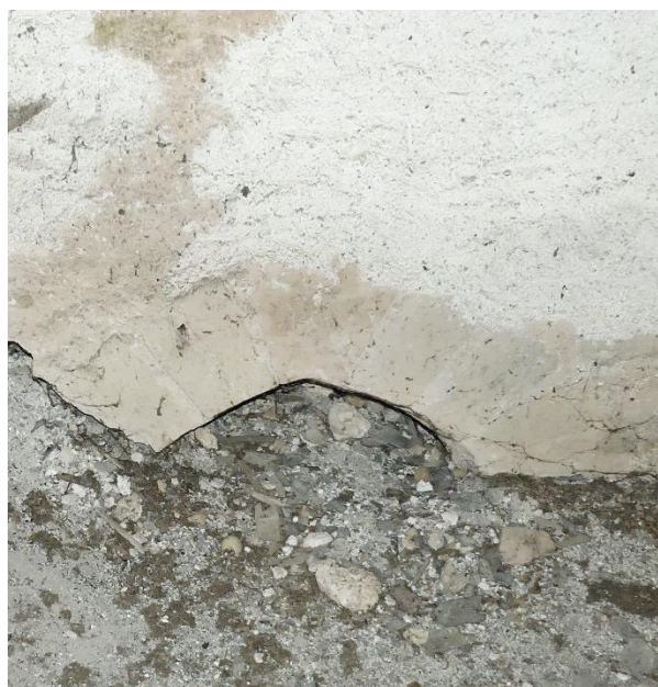
Vestiges d'arc brisé en partie supérieure du mur gouttereau sud de la nef (actuel comble du bas-côté sud) s'apparentant à d'anciennes baies et pouvant être rattachés à la baie cintrée de la façade ouest de la nef. Il s'agit peut être des percements de l'édifice du XIII e siècle
