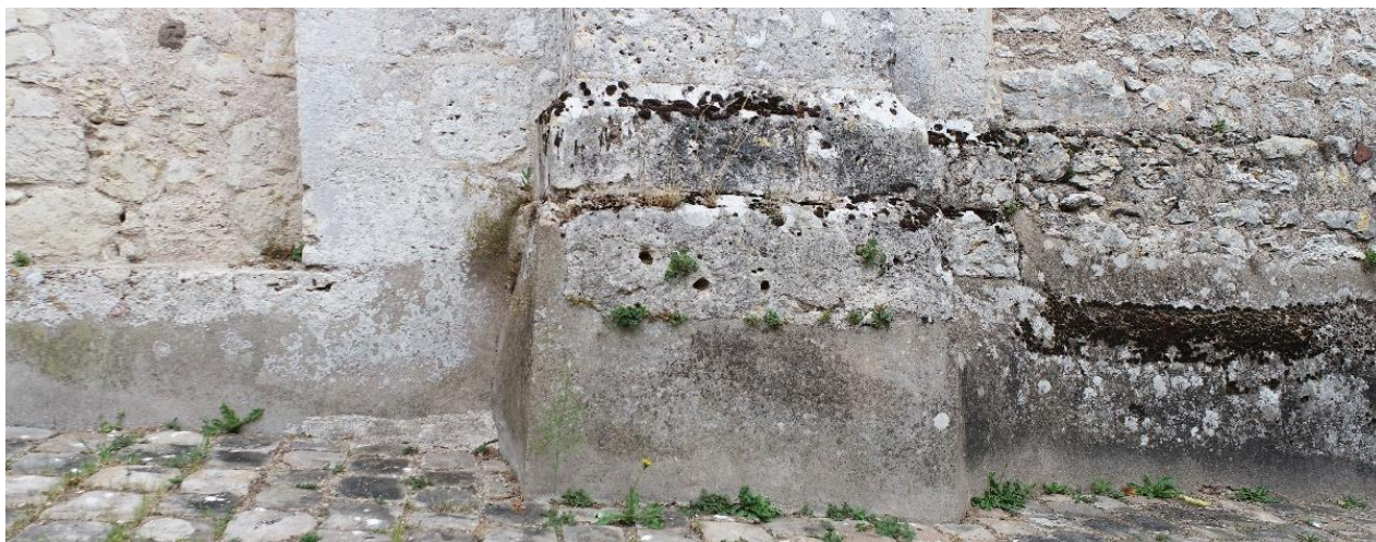
Façade ouest, soubassement enduit ciment
