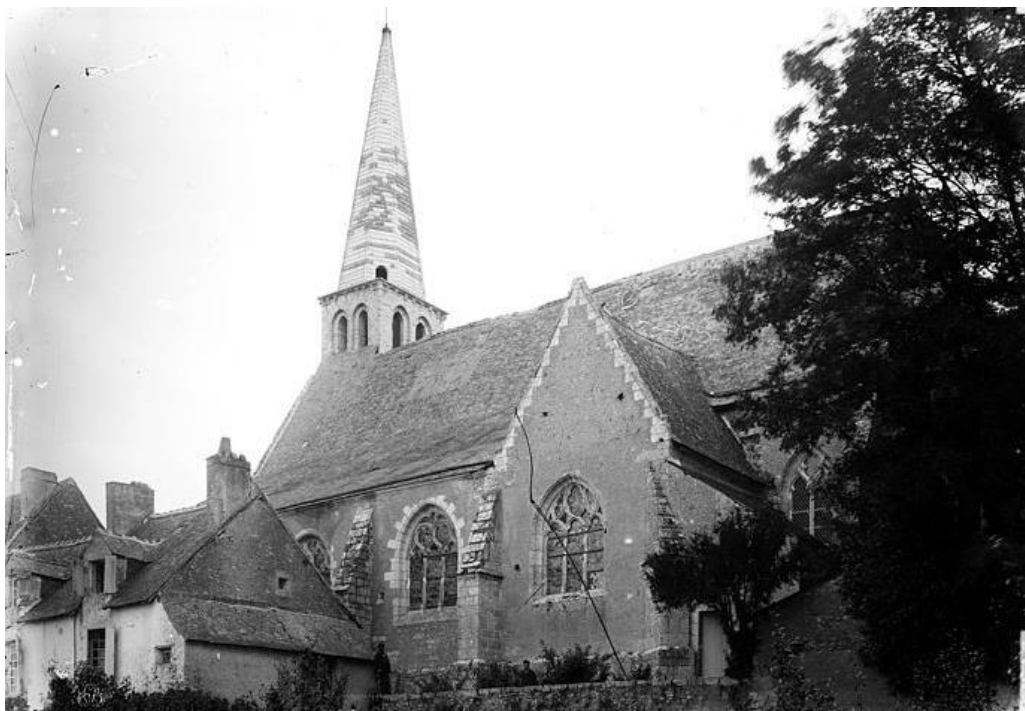
Jean-Eugène Durand (1845-1926) s.d. © pop.culture. Restauration de 1861 de la flèche visible. La toiture du bas-côté sud est continue avec celle de la nef. On semble apercevoir des gouttières rampantes en bas de pente. La rive contre le clocher du versant sud de la couverture de la nef se trouve au-dessus des appuis des baies du clocher
