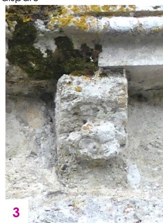
Angle nord-ouest du bas-côté, ancienne gargouille fracturée dont il ne reste qu'une partie. On identifie des jambes sculptées sur le fragment restant, vestige d'un probable personnage dont le tronc a disparu
