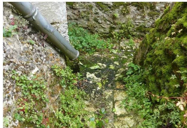
1 Angle nord-est de la chapelle nord, caniveau dont la pente dirige les eaux vers un puits perdu
