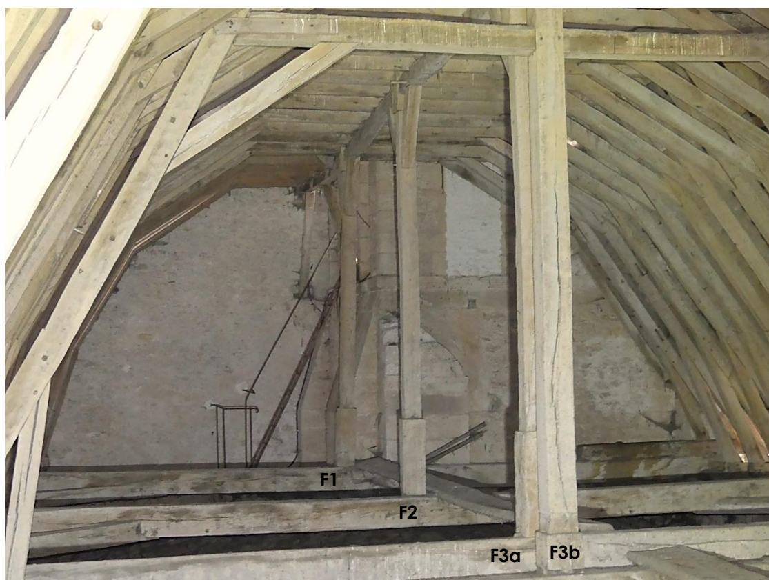
Vue générale de la charpente de la nef vers le clocher (vers l'ouest) Au premier plan : doublement de la ferme
