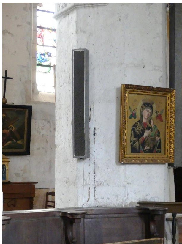
Système de sonorisation par enceintes fixées sur les piliers à la jonction entre la nef et le chœur
