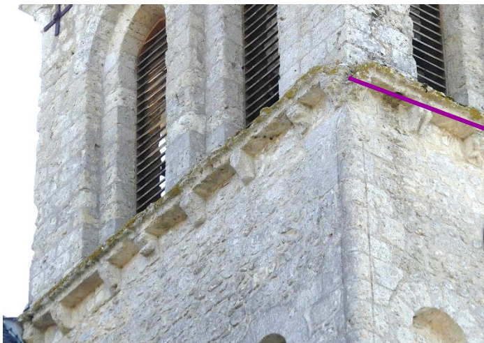
Face est du clocher, bandeau saillant dégradé au centre et à l'angle nord-est
