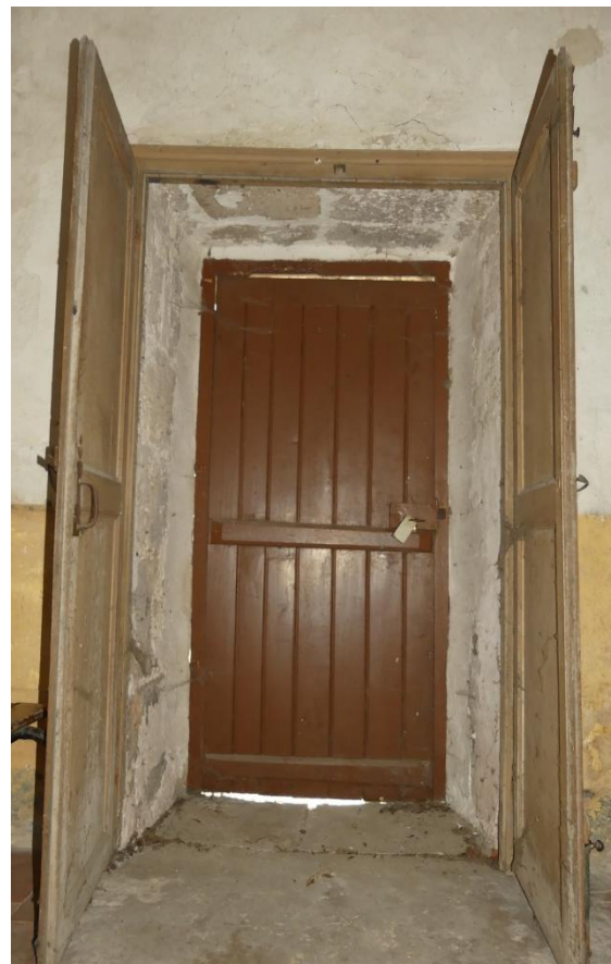
Façade sud, porte de la nef, peinture de la face extérieure vétuste, calfeutrement grossier et lacunaire
