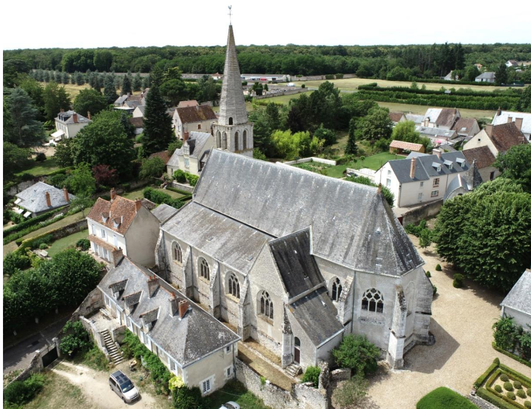
Vue aérienne de l'ensemble depuis le sud-est © agence martine ramat
