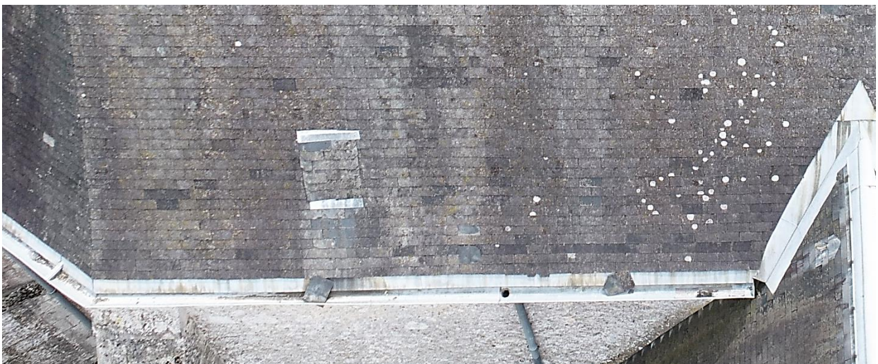
Chevet, ardoise dans la gouttière
