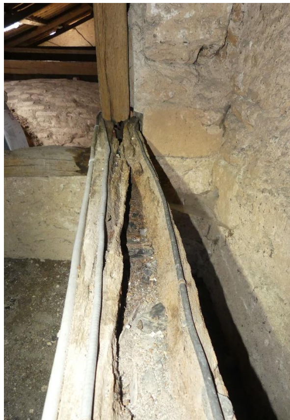
Chapelle Sainte-Radegonde (sud), pied de ferme ruiné et perte de matière importante au cœur du bois de l'entrait suite à l'infiltration
