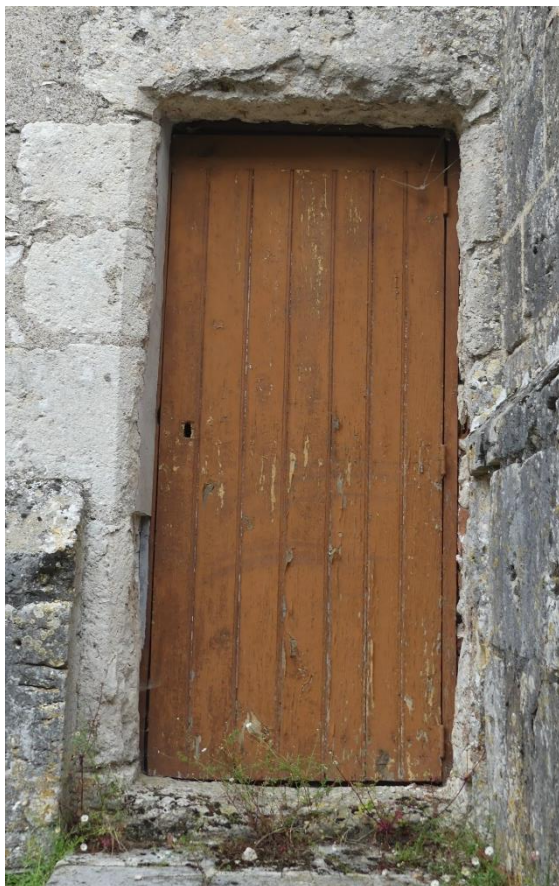
Façade sud, porte de la nef, peinture de la face extérieure vétuste, calfeutrement grossier et lacunaire
