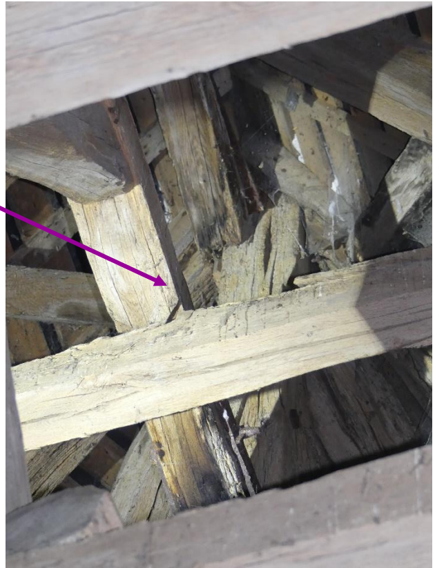
F8 (chœur), multiplication des infiltrations au niveau du poinçon ayant altéré les bois (panne faitière et poinçon ruinés localement)
