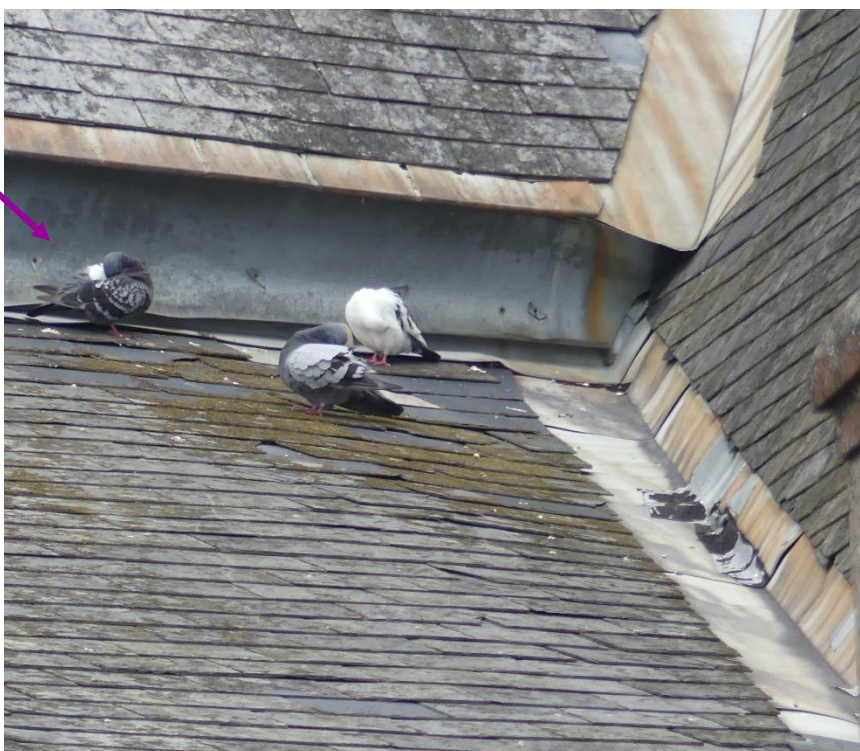
Jonction entre le bas-côté sud et la chapelle Sainte-Radegonde, zingueries corrodées, noue vétuste comprenant des réparations provisoires, présence d'ardoise dans la noue, stationnement de pigeons contribuant à dégrader les ardoises
