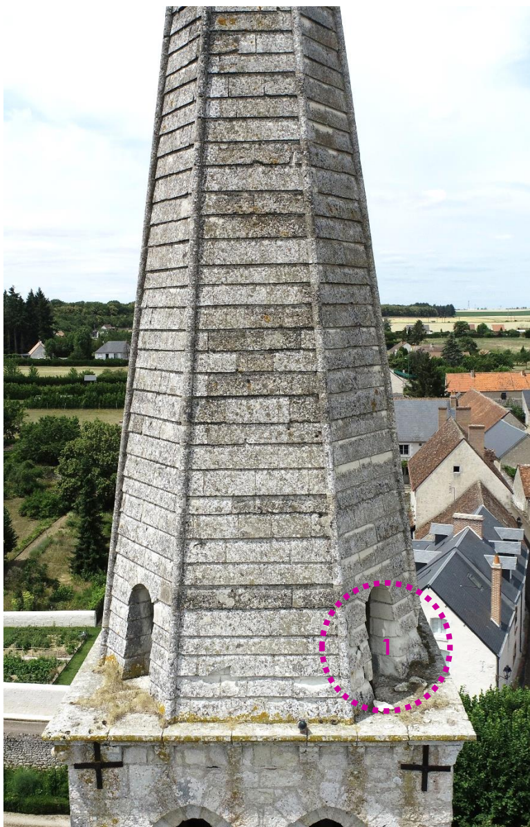
Face sud de la flèche, trois premières assises de pierre dégradées, desquamation par plaques (rejaillissements des eaux de pluie sur le parement), développement de végétation sur la corniche, flèche couverte de lichens
