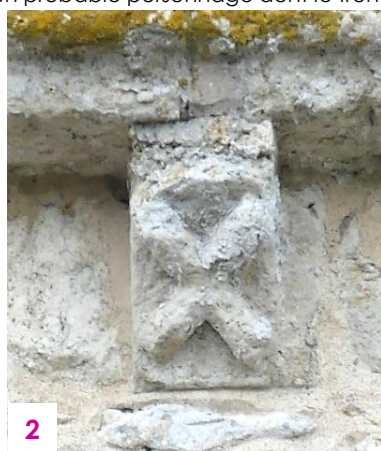
Angle nord-ouest du bas-côté, ancienne gargouille fracturée dont il ne reste qu'une partie. On identifie des jambes sculptées sur le fragment restant, vestige d'un probable personnage dont le tronc a disparu
