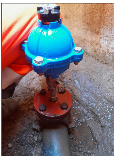
Cour sur Loire - rue des Montreuil - remplacement ventouse
