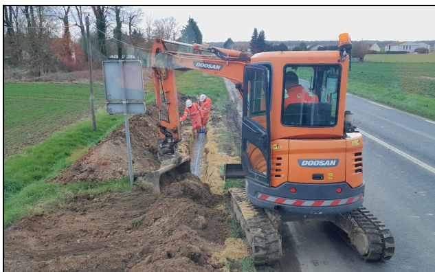
Suèvres - route Nationale de Fleury - renouvellement canalisation 125 amiante-ciment
