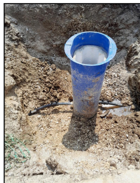
rue de Grivettes - réparation fuite raccord
