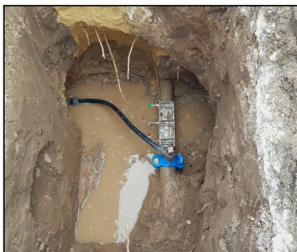
Suèvres - rue du Grand Port - remplacement rpc
