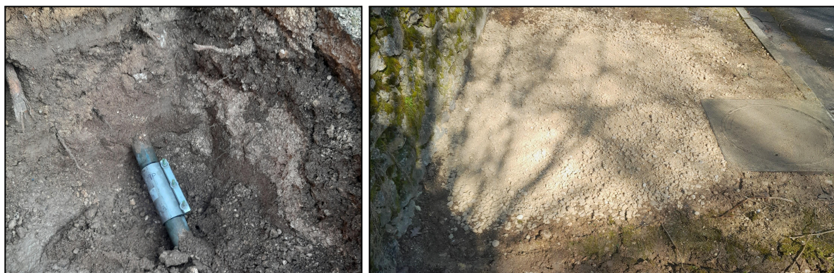
Ménars - rue de la Loire - réparation fuite canalisation 60 amiante-ciment
