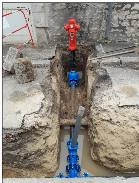
Suèvres - rue Pierre Pouteau - renouvellement canalisation 100 amiante-ciment et branchements
