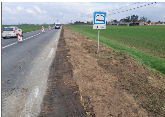
Suèvres - route Nationale de Fleury - renouvellement canalisation 125 amiante-ciment
